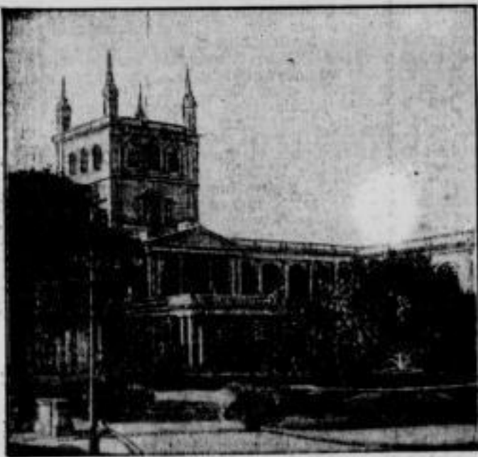
In Südamerika: Das Regierungsgebäude in der paraguayischen Hauptstadt Asuncion, die im Mittelpunkt der Aufstandsbewegung steht. (Wagenborg-Archiv — M.)
