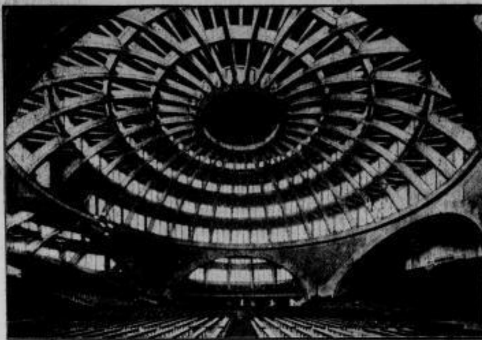
Die Breslauer Jahrhunderthalle wird ausgebaut Das 12. Deutsche Sängerbundesfest und das im nächsten Jahre ebenfalls in Breslau stattfindende Deutsche Turnfest sind der äußere Anlaß gewesen, endlich den Ausbau der im Jahre 1913 als nationales Denkmal errichteten, aber nicht vollendeten Breslauer Jahrhunderthalle in Angriff zu nehmen. Bild in den gewaltigen Kuppelraum. (Weltbild — W.)
