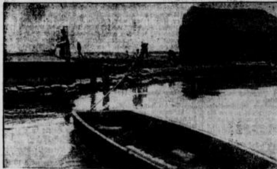
Der Arbeitsdienst im Kampf gegen das Hochwasser eingeleitet Das vom Reichsarbeitsdienst urbar gemachte Spottedebruch in Schlesien wurde in diesen Tagen vom Hochwasser heimgeführt. An mehreren Stellen brachen die Dämme, so daß die Fluten der Spotte weite Strecken überschwemmten. Tag und Nacht wurde vom Arbeitsdienst an der Wiederherstellung der Dämme und Befestigung der bedrohten Stellen gearbeitet. Unser Bild zeigt Arbeiter am Bau eines Schutzdamms. (Eberl-Wagenborg — M.)
