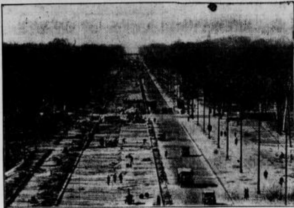
Der Ausbau der Berliner Ost-West-Achse. Blick vom Brandenburger Tor auf die Charlottenburger Chaussee, wo jetzt die Bauarbeiten in vollem Gange sind. Die Ausmaße der Verbreiterung dieser wichtigen Berliner Ost-West-Achse erkennt man am deutlichsten bei einem Vergleich mit der Hälfte der alten Fahrbahn, die rechts im Bilde noch zu sehen ist. (Weltbild-Wagenborg — M.)
