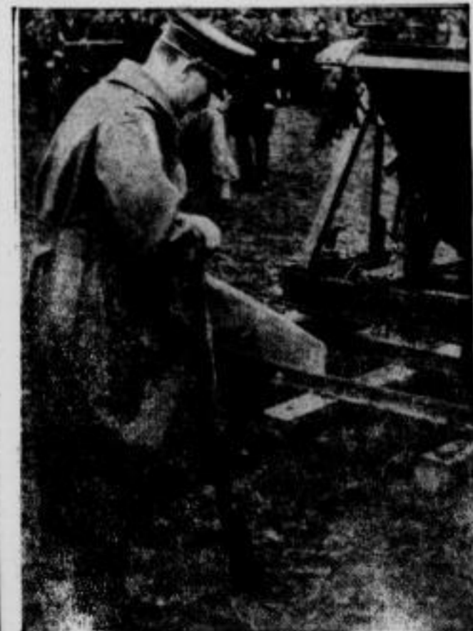
Der Führer beim ersten Spatenstich (Bildtelegramm.) (Scherl-Wagenberg — M.)
