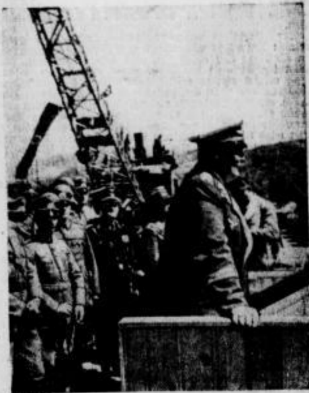
Hermann Göring tat den ersten Spatenstich zu den Reichswerken in Linz. Generalfeldmarschall Göring spricht anlässlich des ersten Spatenstiches zu den Reichswerken Hermann Göring in Linz an die Arbeiter. (Siehe auch unseren heutigen Bericht.) (Weltbild-Bogenberg — W.)
