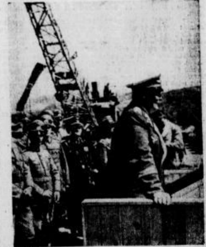
Hermann Göring tat den ersten Spatenstich zu den Reichswerken in Linz. Generalfeldmarschall Göring spricht anlässlich des ersten Spatenstiches zu den Reichswerken Hermann Göring in Linz. (Siehe auch unseren heutigen Bericht.) (Weltbild-Bogenberg — W.)
