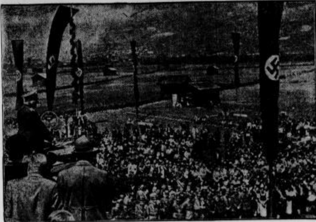
Ministerpräsident Generalfeldmarschall Göring eröffnete den Baubeginn für das Tauernkraftwerk. Am Montag eröffnete Ministerpräsident Generalfeldmarschall Hermann Göring, der Beauftragte des Führers für den Vierjahresplan, bei Zell am See bekanntlich mit dem feierlichen Spatenstich den Baubeginn für das größte
