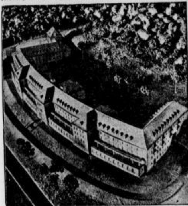
Von einer Gesundheitsburg in Bayreuth. Im Rahmen einer mächtvollen Rundgebung an der Hohen Warte in Bayreuth gab Gauleiter Wähler den Befehl zum Baubeginn der Gesundheitsburg des Gaues. Der Bau gliedert sich in eine Kinder- und Säuglingsabteilung, eine Abteilung für Behandlung und Entbindung von Müttern, Lehr- und Wohnräume für die NS-Schwester und die dazu gehörigen Wirtschaftsgebäude. — Das Modell der Gesundheitsburg. (Weltbild-Wagenborg - M.)
