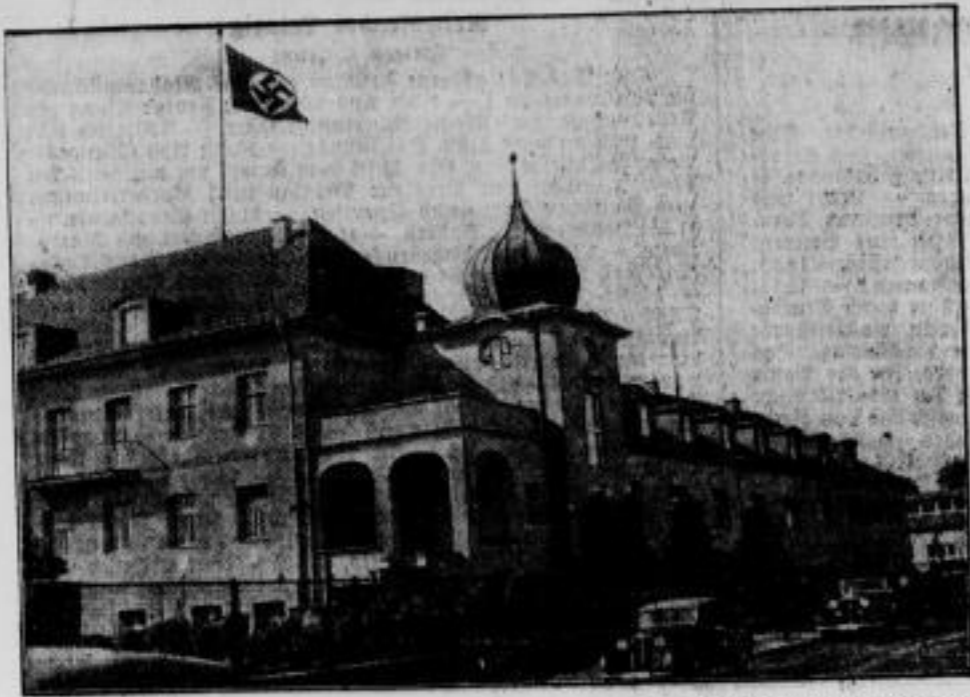
Feierliche Schlüsselübergabe in neuen Kaiser-Wilhelm-Institut für Physik Mit der feierlichen Schlüsselübergabe an den Leiter des Instituts, Professor Dr. Debye, wurde das neuerrichtete Kaiser-Wilhelm-Institut für Physik in Berlin-Dahlem, das über vorbildliche technische Einrichtungen verfügt und zu den modernsten Forschungstätten der Welt gehört, seiner
