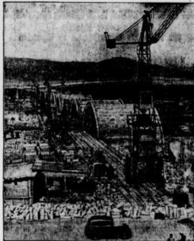
Ein neues gewaltiges Brückenbauwerk der Reichsautobahn
