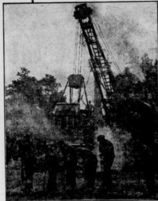
Arbeiter, Brechstämmer und Bagger nehmen auch auf dem Königsplatz die Arbeit auf. (Zerl-Wagenborg / W.)
