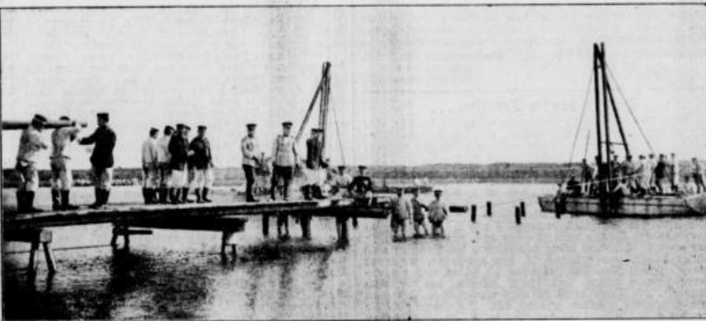
Riesauer Pioniere der Vorkriegszeit beim Bau einer Wehrlösbrücke über den Elbstrom
