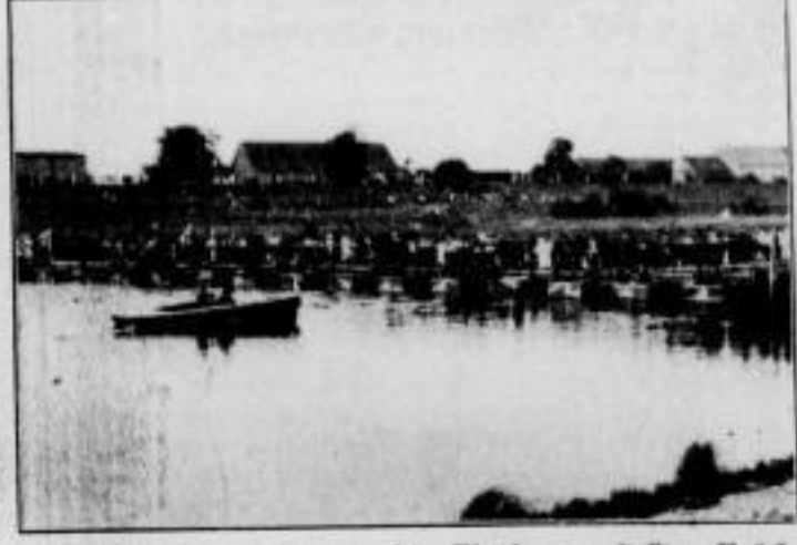
„Hochbetrieb“ auf der von den Pionieren erbauten Brücke (Aufnahmen (3), J. Gostislow)
