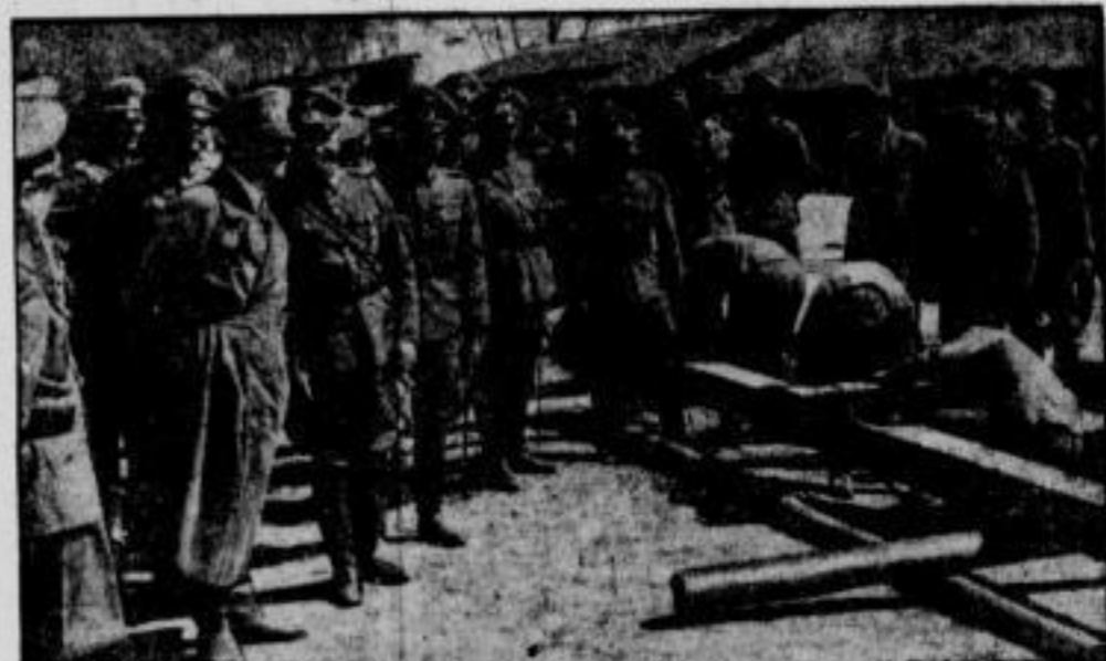
Brückenbau der Pioniere in Gegenwart des Führers. Ein Bild von der Standortbesichtigung des Führers und Obersten Befehlshabers der Wehrmacht in der Ostmark. — Die Pioniere in Krems beim Brückenbau in Gegenwart des Führers. (Weltbild-Wagenborg - M.)
