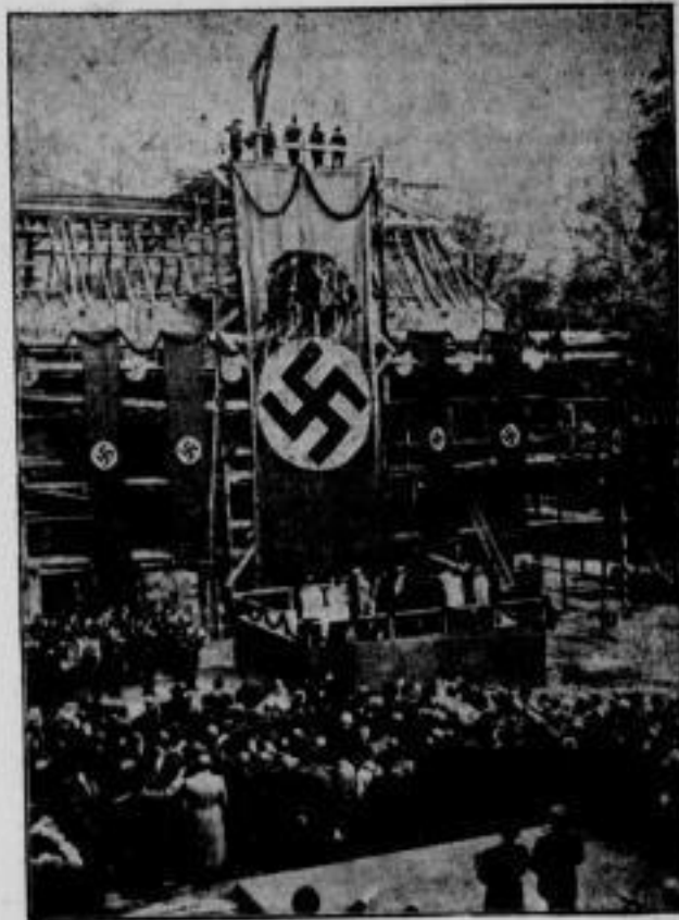
Richtfest beim neuen Dienstgebäude des Reichsaußenministers Am Donnerstag fand in Berlin das Richtfest für das neue Dienstgebäude des Reichsaußenministers statt, das durch den Umbau des alten Präsidentenpalais entsteht. — Die Richtkrone wird aufgesetzt. (Weltbild-Wagenborg-M.)
