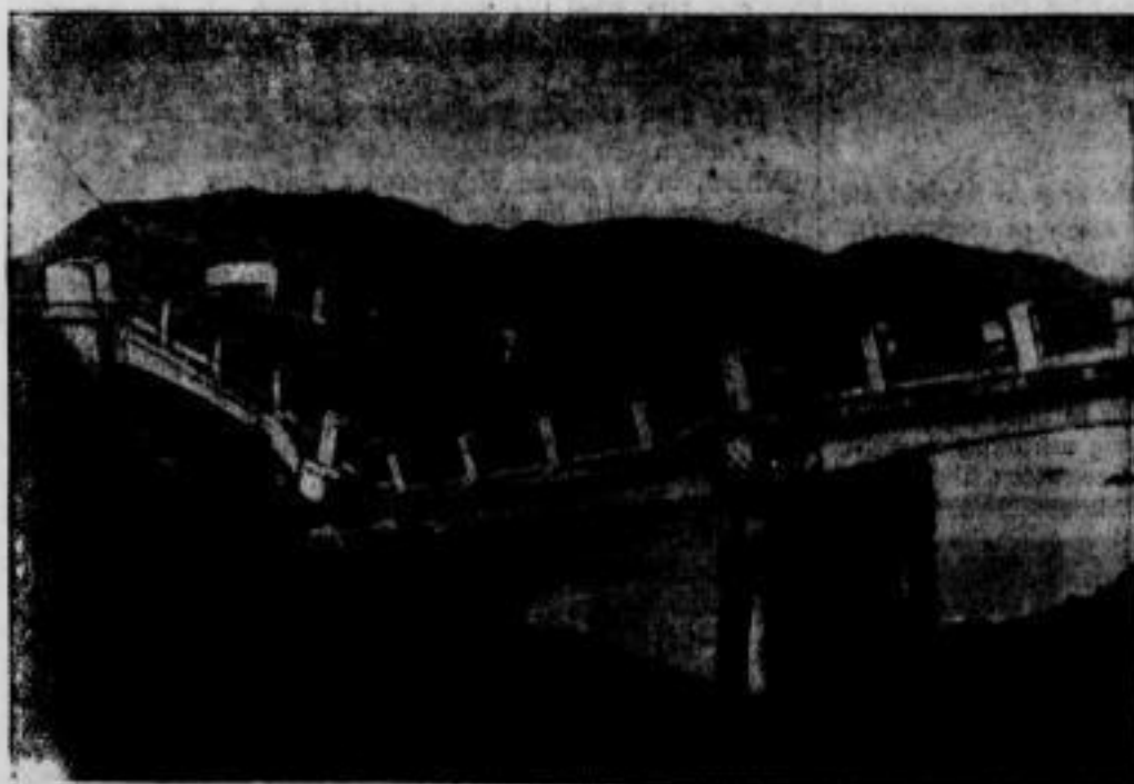
Gesprenzte Brücke vor Salonik wurde rasch wieder befahrbar gemacht und bildete dann sein Hindernis mehr für unsere vordrückenden Truppen (P.R. Radio-Atlantic-Wagenborg-W.)
