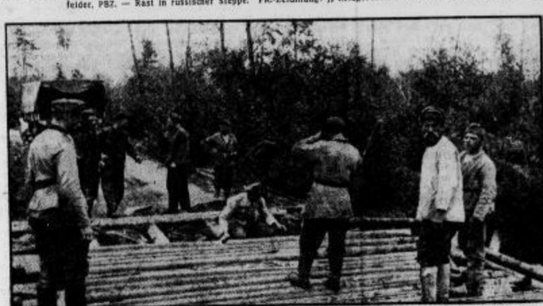
Links: Hilfswillige bauen einen Knäpeldamm an der Ilmensee-Front. Meter um Meter rückt der Damm vor und dringt tief in den Sumpfwald ein. PK-Aufnahme: Kriegsberichtler Pospischil, HH. — Rechts: Eine bolschewistische Fallschirmagentin wurde gefaßt. Dem Führer eines Kommandos der Sicherheitspolizei wurde von Ortsbewohnern gemeldet, daß über ihrem Gebiet ein Fallschirmabwurf beobachtet wurde. Das Kommando nimmt sogleich die Spur auf. Bald in einem Baum hängend den Fallschirm und wird bald darauf auch der Agentin habhaft, die dann zum Verhör geführt wird. PK-Aufnahme: Kriegsberichtler Klügardt, HH.
