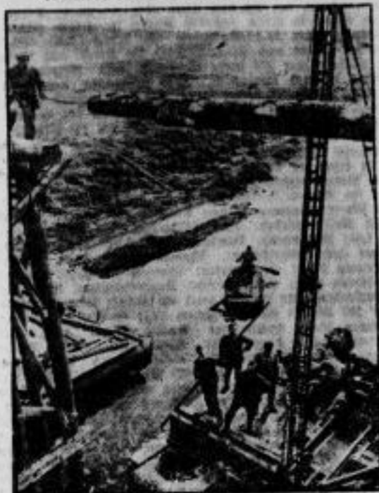
Die Arbeiten an den Joche, das Bohren der Löcher für die eisernen Verbindungsbolzen, das Ausstimmen für die Tragbalken, das Sägen und Flechten für diese Brücke im Osten geschieht in Höhen von acht bis zehn Meter über dem Wasserspiegel. FK-Aufnahme: Kriegsberichterstatter Dreyer, HH.
