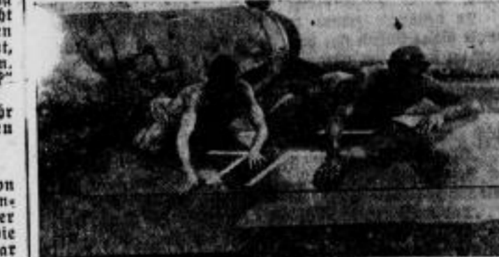
Spiegelblech werden die Flächen und der Rumpf poliert, um das Höchstmaß an Geschwindigkeit aus den Flugzeugen des Japanschwunders herauszuholen.
