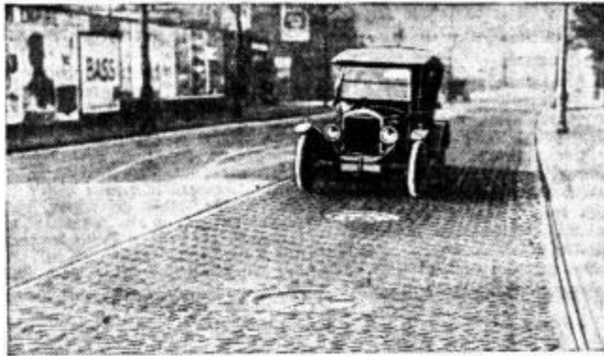
Eine ganz originelle Straßenpflasterung zum Schutze gegen Schleudern der Automobile ist in Aktion, in der Nähe Londons, versucht worden und hat sich bisher ausgezeichnet bewährt. Sie besteht aus kleinen Folgeböden, die mit Gummistreifen belegt sind.
