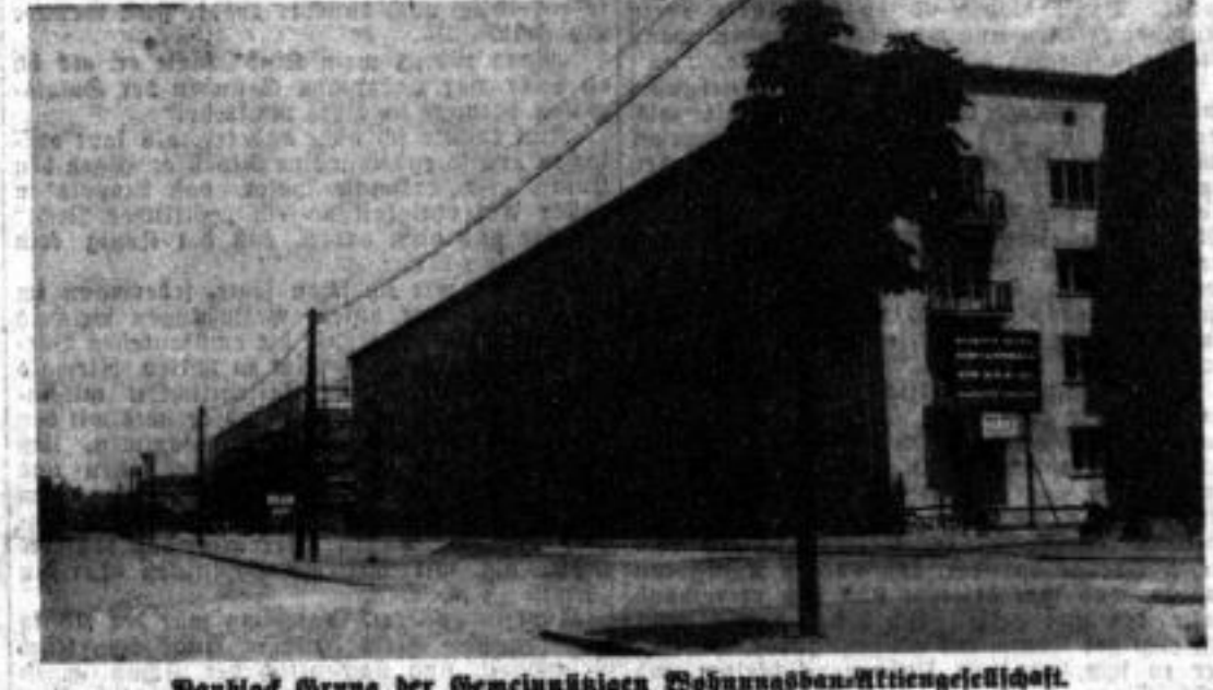
Wohnblock Gruna der Gemeinnützigen Wohnungsbaugesellschaft, Neubauten an der Frauenheimer Straße.
