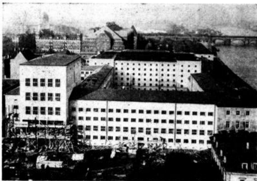
Blick vom Turm des Fernheizwerkes auf den Landesfinanzamtsneubau Dresden.
