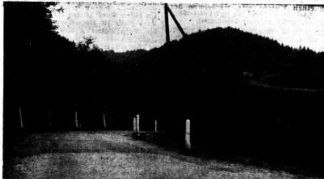
Dieses Bild läßt sowohl den jetzigen beachtlichen Raumgewinn bis zu 2 Meter, durch Abtragen des Weisfelsens und Danges, erfreulichen Sichtgewinn selbst im Kurvenradius, die begründenswerte landschaftliche Verschönerung als auch den Fußgänger durch das abfallbestreuten abgetrennten Fußweg rechts an grabenloser Böschung ermessen.
