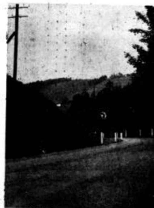
Gleicher Gewinn wie bei Bild 2 ins Auge springend; dazu die Zufüllung des Steinbruches, Fußwegabtrennung durch weiße Rammstühle. — So ließe sich noch manche verhasste Kurve in ansehnlicher Weise durch gleich erzielte Arbeitsleistung (hier für zehn erwerbslose Familienväter sechs Wochen) erschießen.
