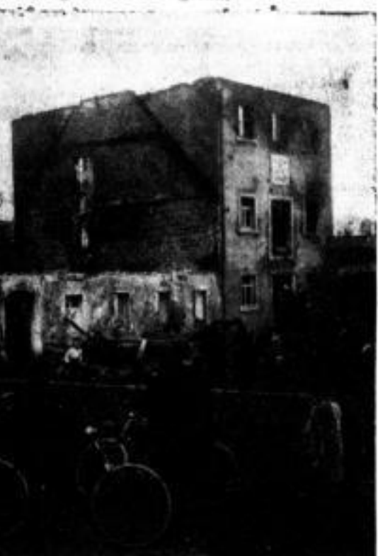
Großfeuer in der Altmühle in Altstadt b. Stolpen. Das Wohnhaus und das ausgebrannte Röhrlengebäude.
