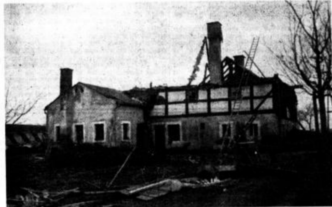
Der Brand in Sabitzdorf. Montag nacht brach im Anwesen des Wirtschaftsbefizers Kurt Erler Feuer aus, das großen Schaden anrichtete.
