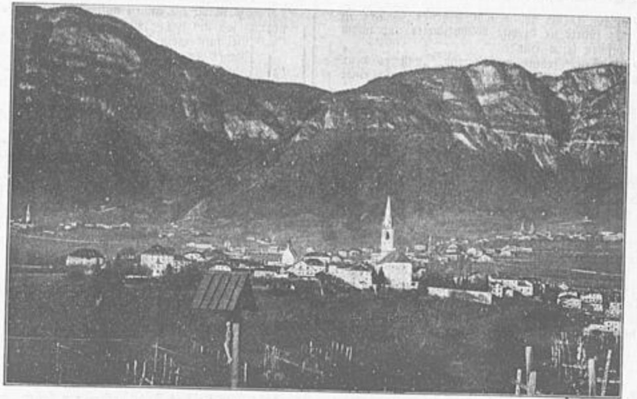
Rathern mit der Trace der Mendelbahn.
