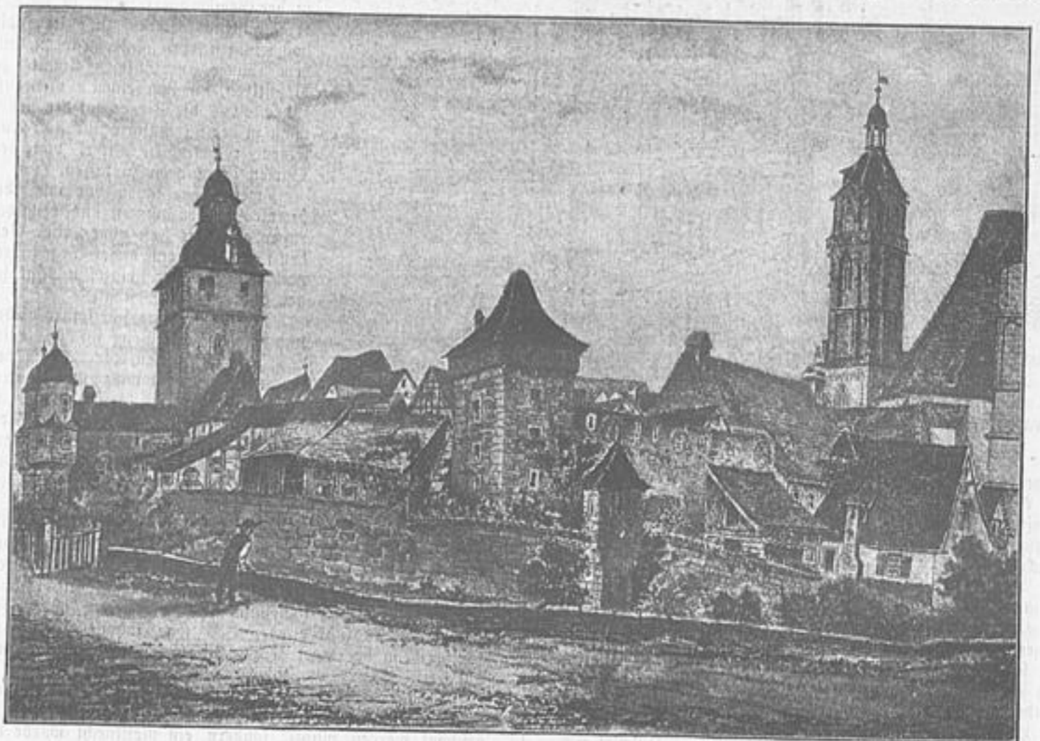
Ansicht von Weisenburg.
