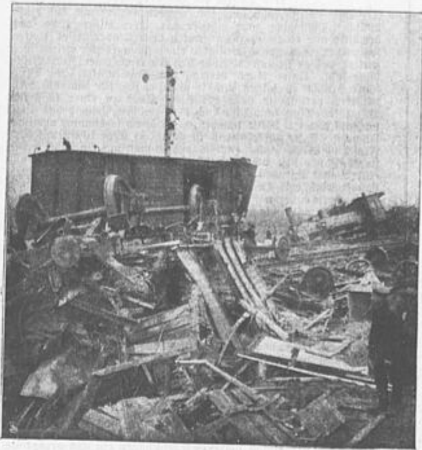
Vom Eisenbahn-Unglück auf der Station Seelze zwischen Hannover und Wunstorf: Die Unglücksstätte.
