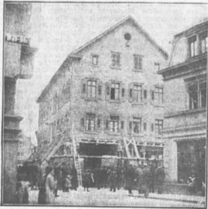
Von der Einsturz-Katastrophe in Nagold (Württemberg): Der gehobene Gasthof „Zum Hirsch“ vor dem Einsturz.
