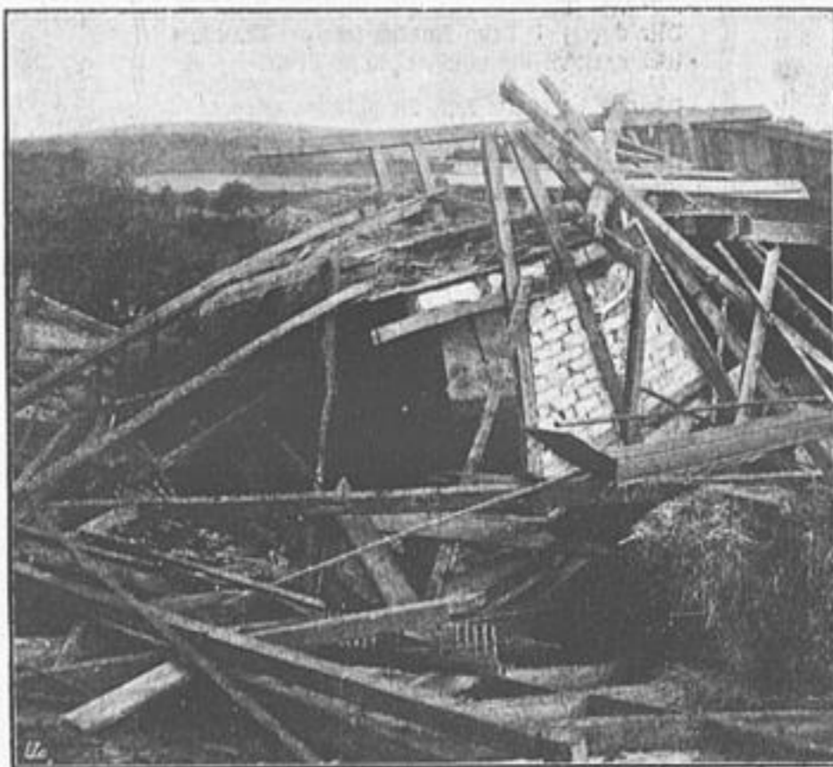
Von der Sturmkatastrophe in der Umgebung von Solinzen: Zerstörte Häuser in der Ortschaft Dorperhof.
