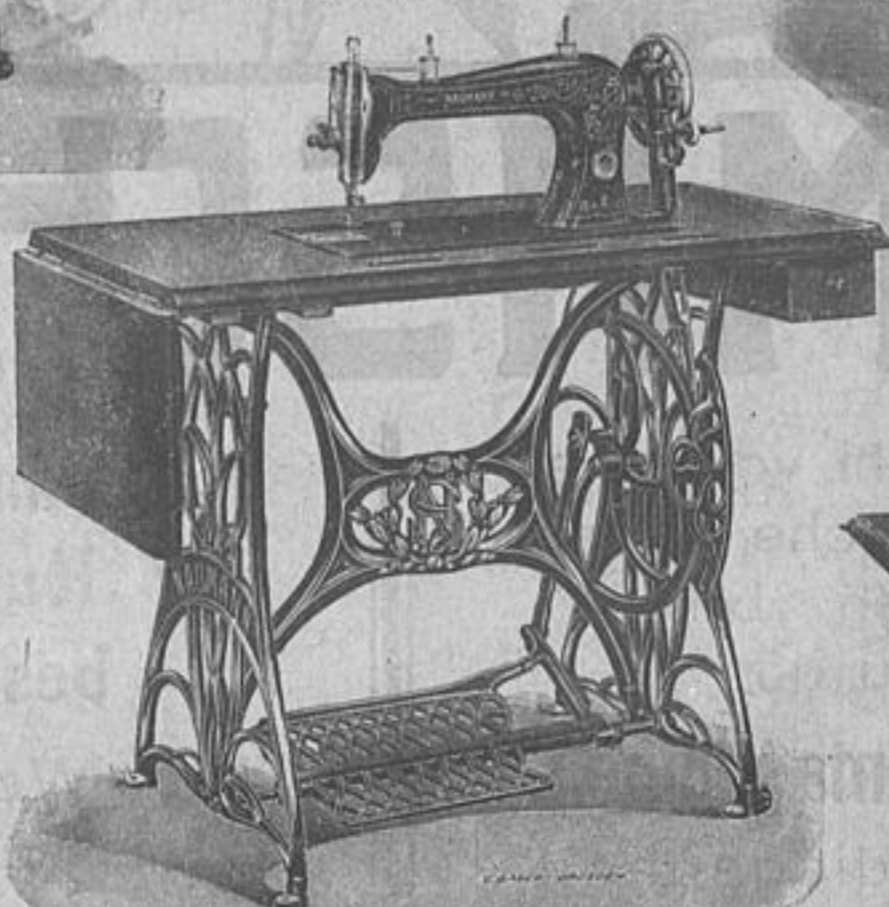
NAUMANNS Handwerker-Ringschiffchen-Nähmaschine Lit. C mit Klapptisch für schwere Schneider-, Konfektions- und Lederarbeiten, Militärwerkstätten usw. Dieselbe Maschine, jedoch mit Rollfuß, für Schuhmacher und Schäft- fabrikation, ebenso für Kappenmacher, Besatzarbeit usw.
