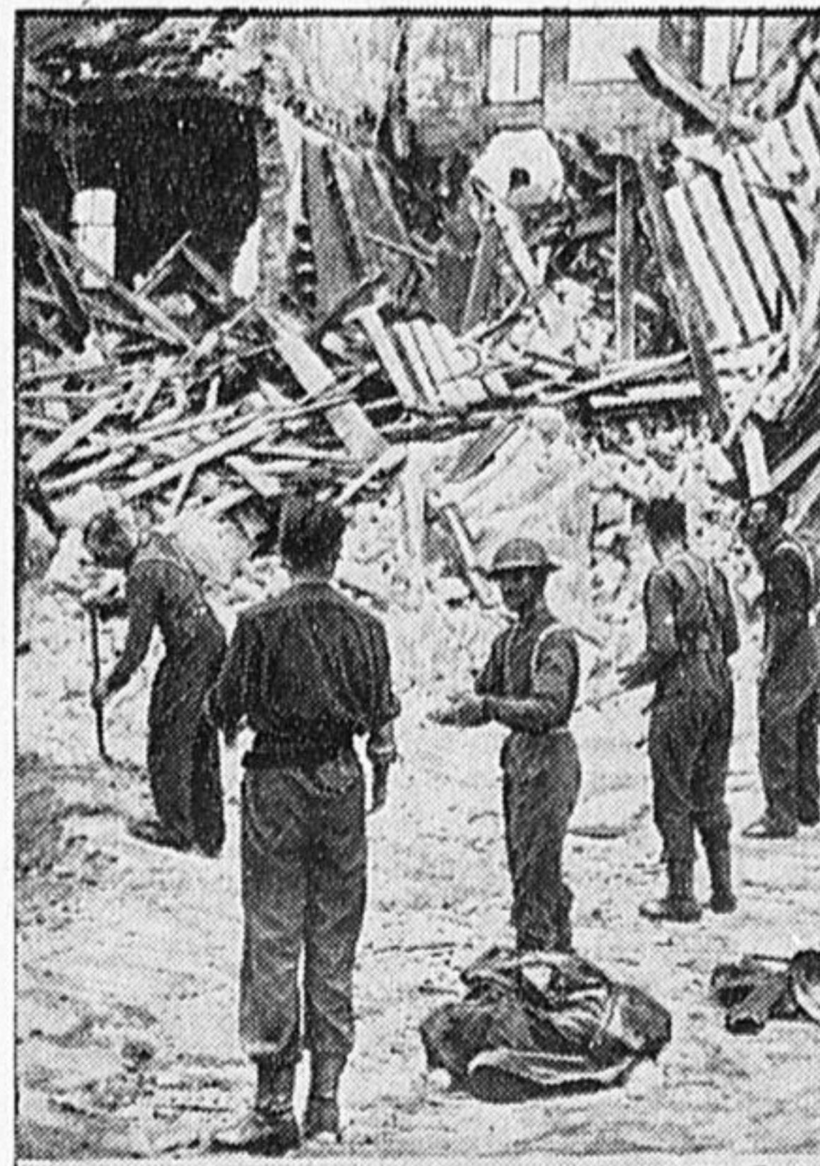
Einfach englischer Kriegsgefangener bei den Aufräumarbeiten in Calais. Sicher wird sich jeder von ihnen bei dieser verdient harten Arbeit über die sinnlosen Zerstörungen, die der englische Krieg hier anrichtete, nun seine eigenen Gedanken machen. (P.R. von Kaiser, Zehrl, M.)
