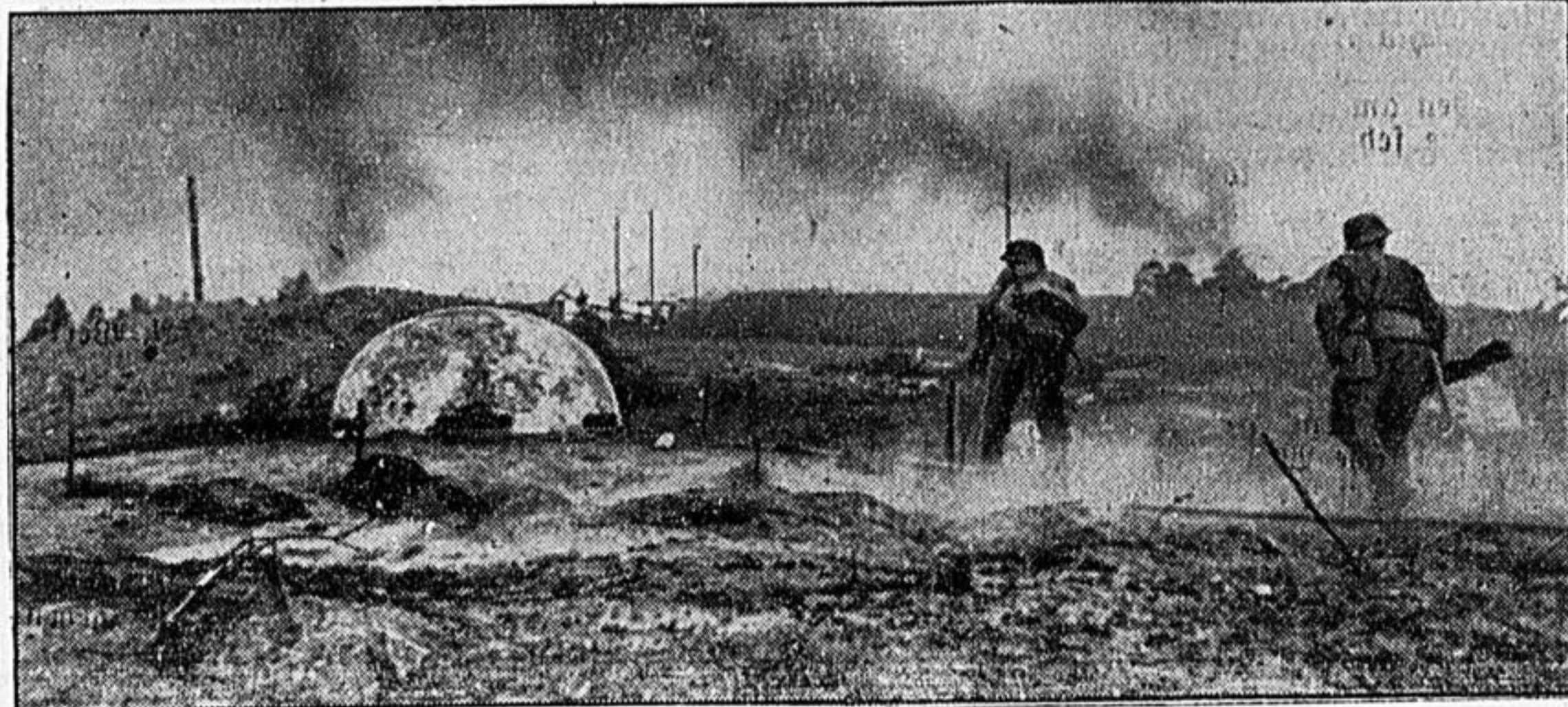
Hartes Kämpfen im äußersten Nordosten Finnische Soldaten stürmen einen Sowjetbunker.
