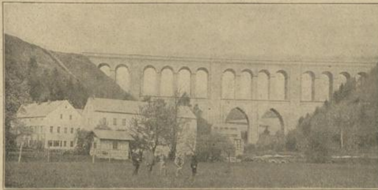
Waldheim. Eisenbahnviadukt Diedenmühle
