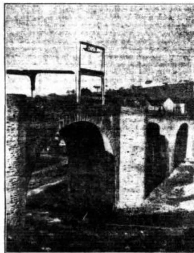
Hauptbogen mit darüber bef. Hängebahnstützung
