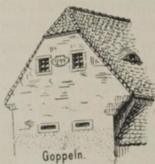
Fig. 188. Schildartige Giebelmauer.
