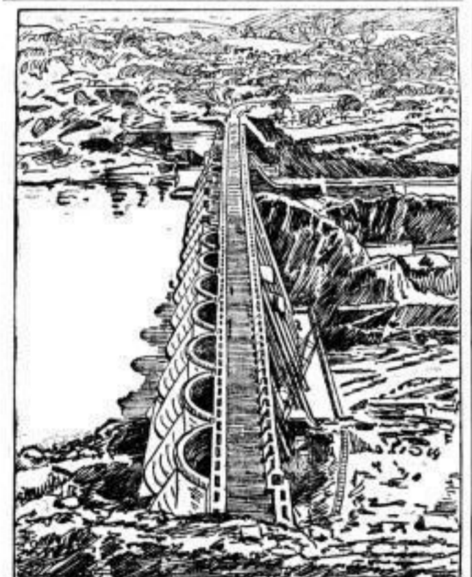
Die neu eröffnete große Talsperre von Santa Chiara auf Sardinien, die jährlich 80 Millionen Kilowatt elektrische Energie liefern kann
