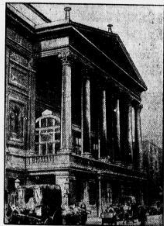
Londoner Oper wird abgerissen.
