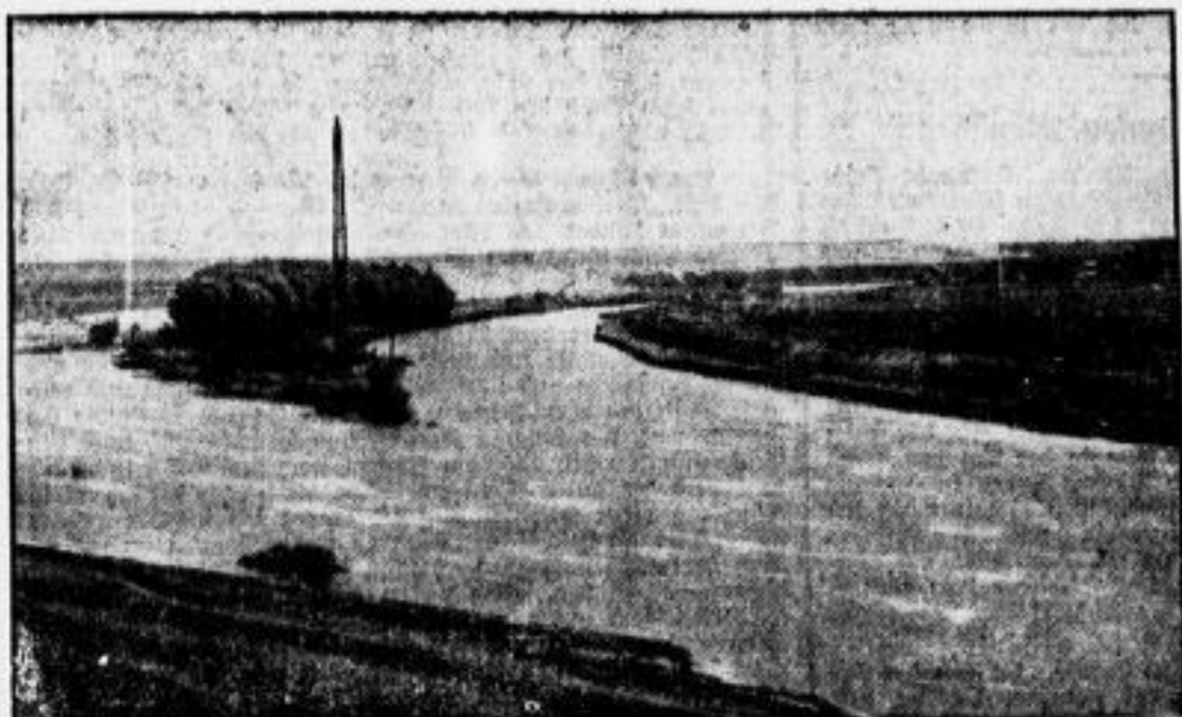
Blick auf den Stichkanal der Saale in Eiferfurt bei Bernburg (Anhalt), der mit größter Beschleunigung gegraben werden mußte, um den Wassermassen, die sich durch den Kahlberg-Absturz angestaut hatten, Abfluß zu verschaffen.
