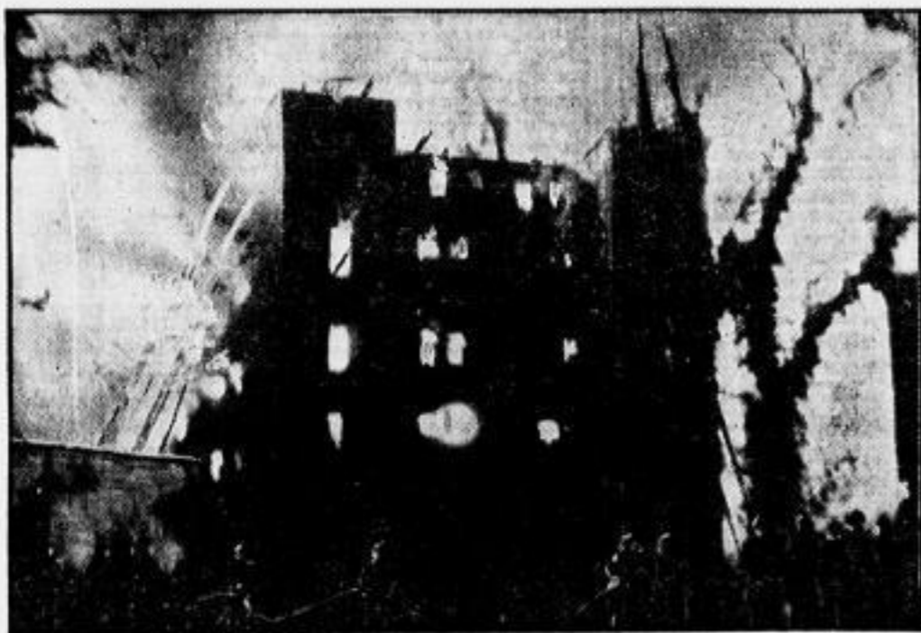
Deutschlands größter Dampfspeicher niedergebrannt. Der nächtliche Riesenbrand des Groß-Speichers in der Zellfabrik von Wittenberge. Der Speicher brannte völlig aus, gewaltige Borräte an Rapsfasen und Ölen wurden vernichtet.
