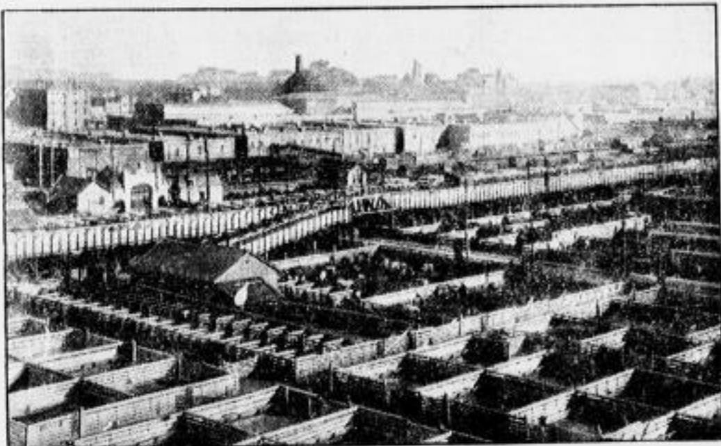
Überblick über das Schlachthofviertel.
