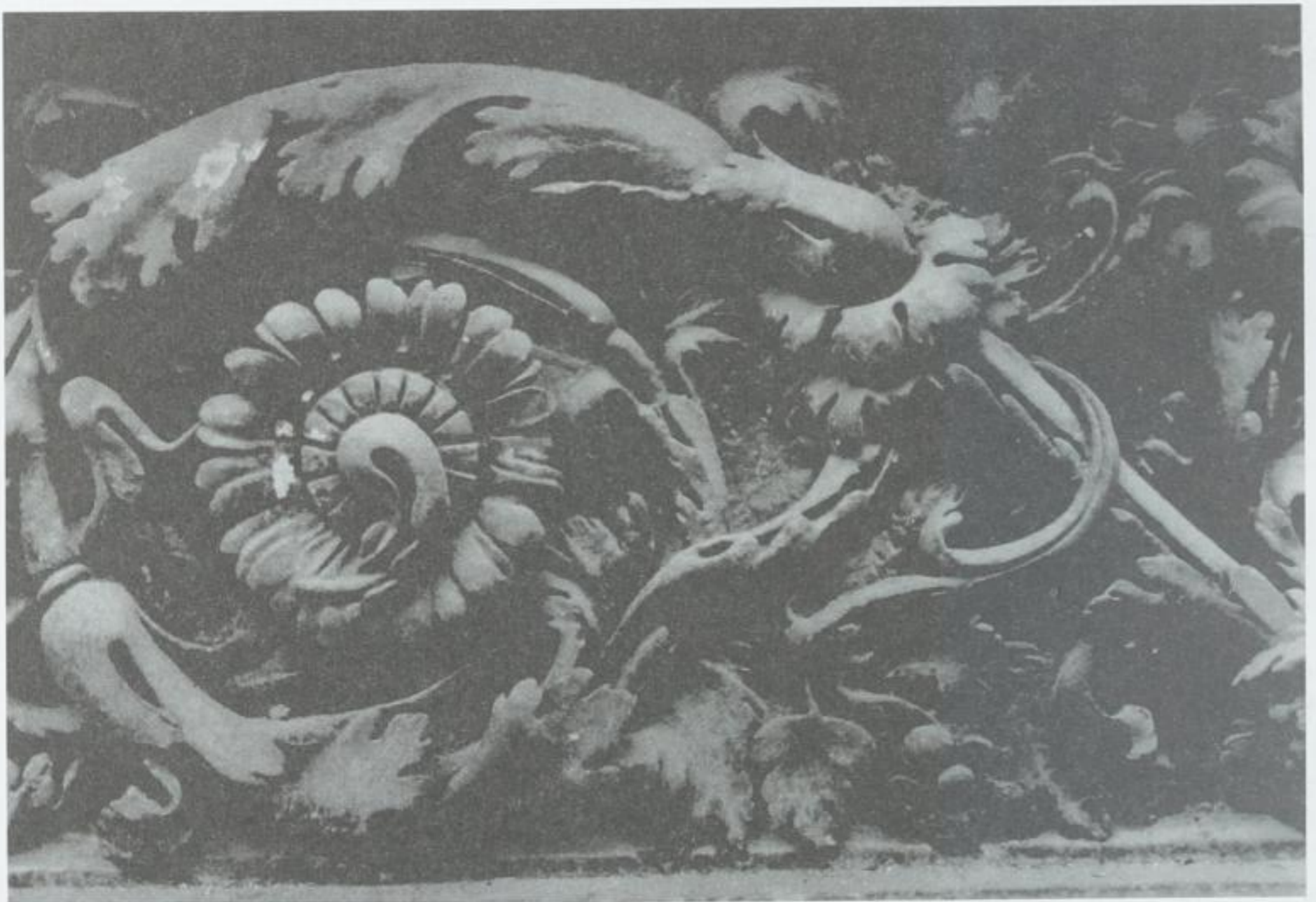
Abb. 11: Dresden, Residenzschloss, Schlosskapellenportal, Akanthusfries im Geison, Ausschnitt, 1555, vor der Reinigung mit Laser
