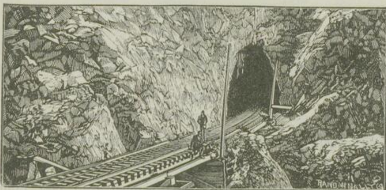
Einfahrt in den Raton Tunnel.
