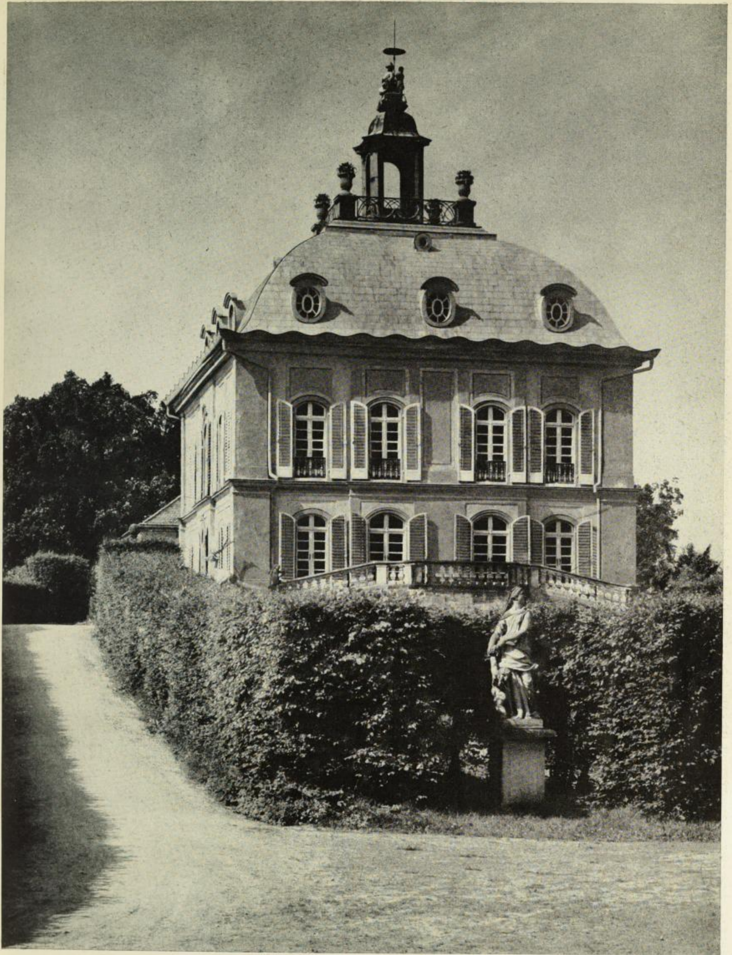
Das Fasanerieschloßchen am Großen Teich in Moritzburg, 1769 bis 1782 erbaut
