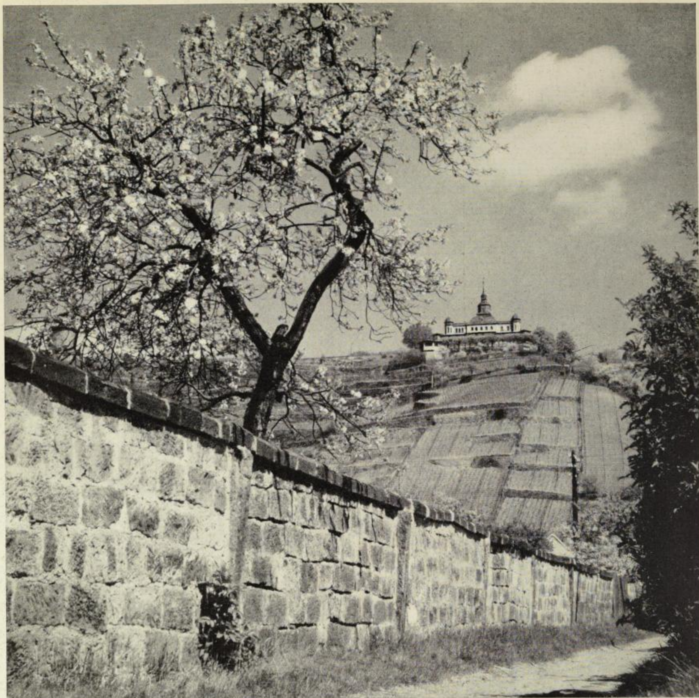
Oberlößnitz, das Spitzhaus, Mittelbau um 1680
