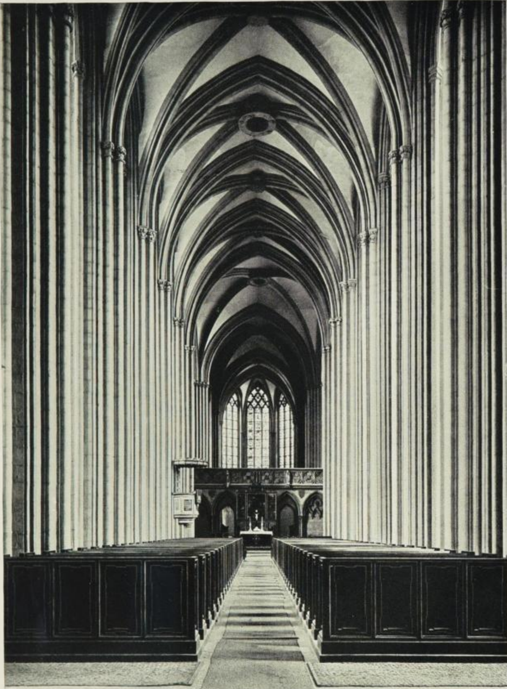
34. Das Hauptschiff des Domes vom Westportal aus. Blick durch und über den Lettner in den Chor. S. 54
