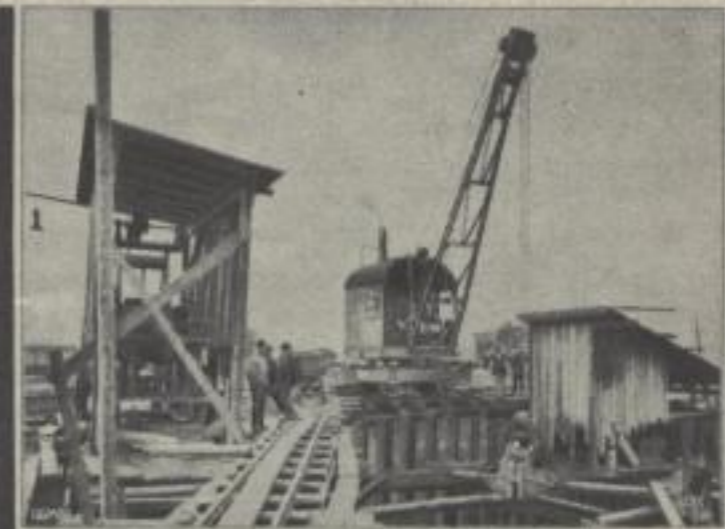
Abb. 141—142 (Buchseite 63): Die Kampnagel-Hafenkrane in Parade- stellung (141) sollen von „höchster Leistungsfähigkeit“ sein. — In Ar- beitsstellung stehen die Krane (142), die von AEG-Drehstrom-Doppel- Kranmotoren angetrieben werden, die die Umschlagkosten senken, worunter man sich schon mehr vorstellen kann
