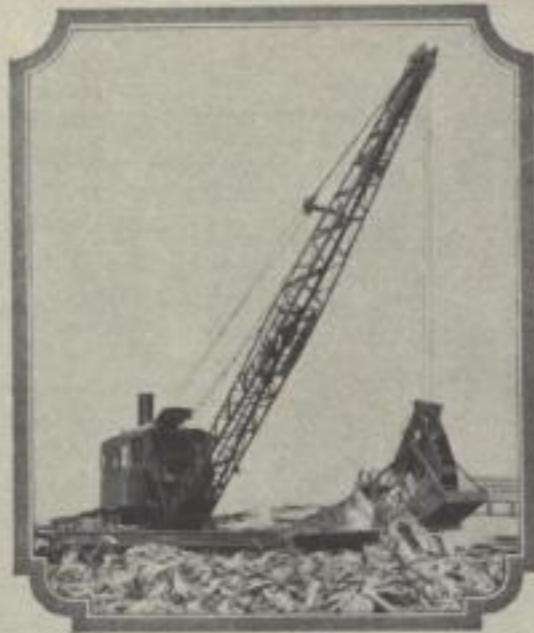
Abb. 141—142 (Buchseite 63): Die Kampnagel-Hafenkrane in Parade- stellung (141) sollen von „höchster Leistungsfähigkeit“ sein. — In Ar- beitsstellung stehen die Krane (142), die von AEG-Drehstrom-Doppel- Kranmotoren angetrieben werden, die die Umschlagkosten senken, worunter man sich schon mehr vorstellen kann
