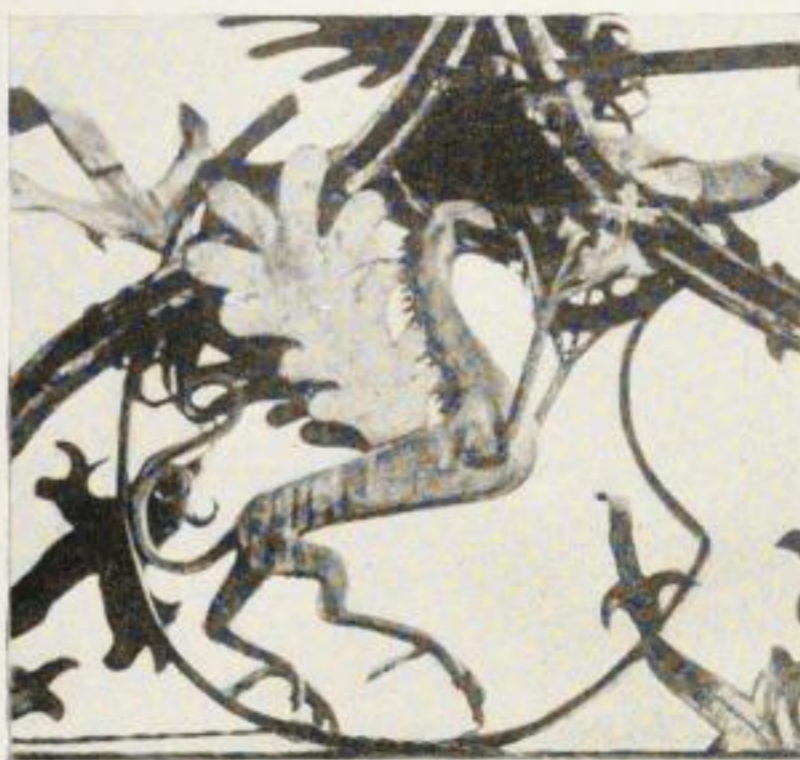
Durch Verschweißen und Vernieten zusammengefügtes Gitter mit Einzelheiten.
