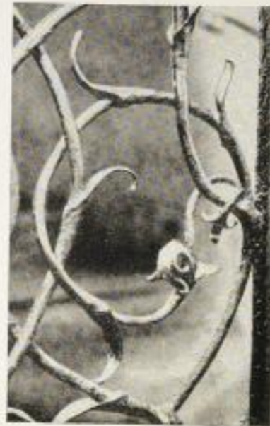
Gittertür mit angeschweißten Blättern und Ranken. Wappen- modellierung durch eine auf- geschweißte Schicht.
