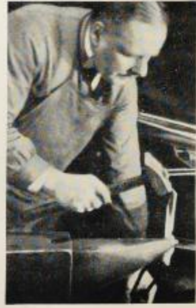
Darstellung des Spaltens, 2 bis 4 Strecken, Ausschmieden und Rollen eines abgespaltenen Lappens.
