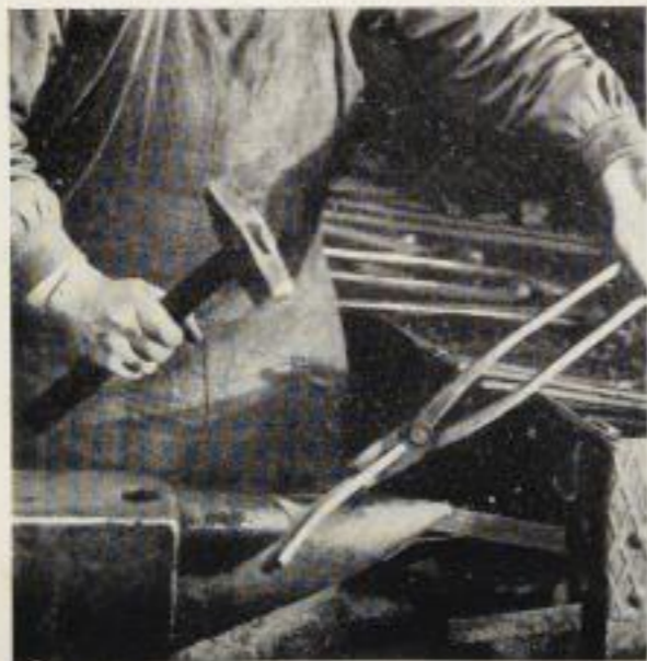
Darstellung des Spaltens, 2 bis 4 Strecken, Ausschmieden und Rollen eines abgespaltenen Lappens.
