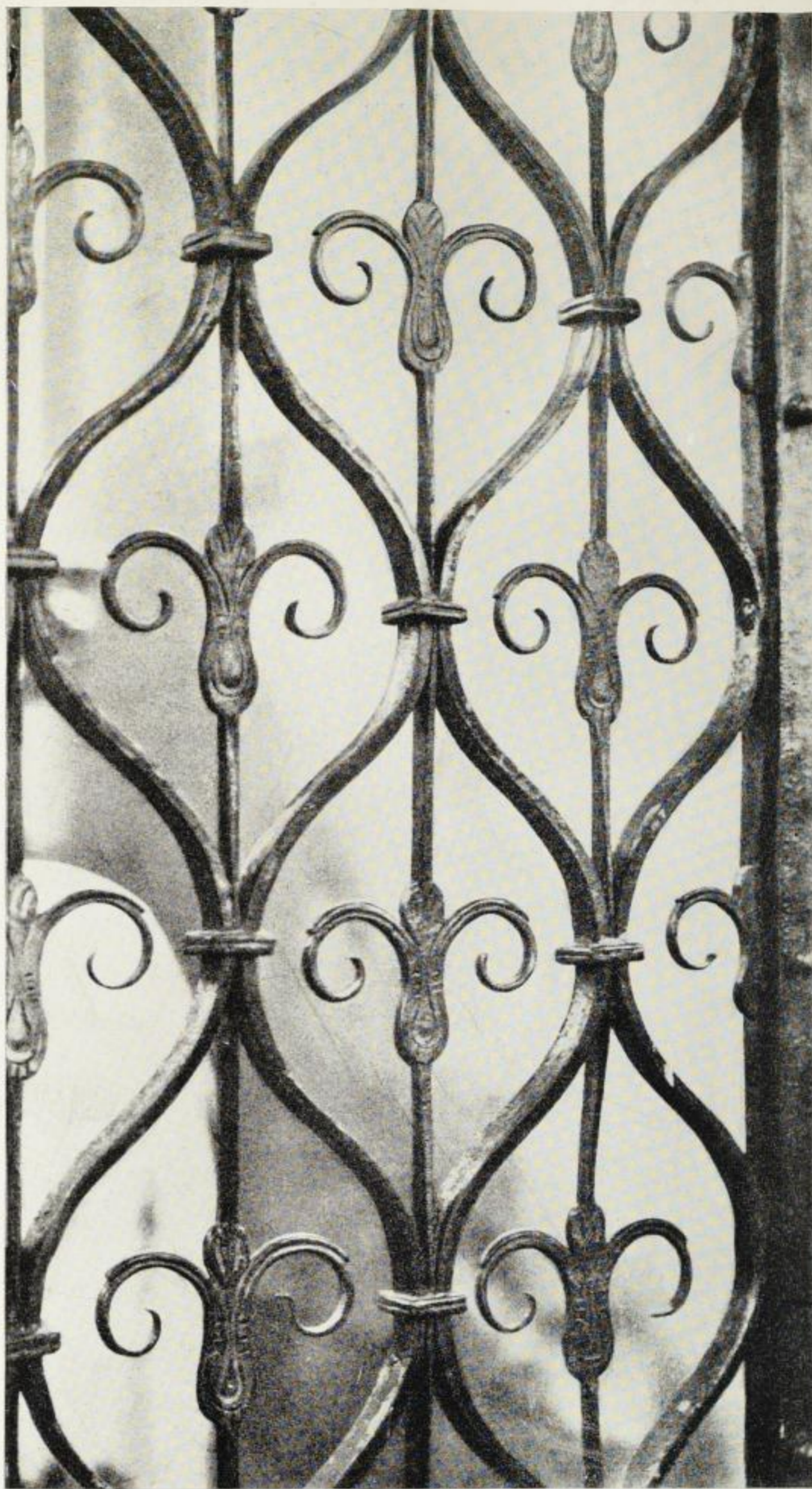
Teilstück eines Gitters, gestaltet durch Stauchen, Breitziehen, Spalten, Rollen, Einhauen und Aufziehen von Bündeln.
