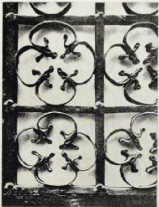
Gittertürechen mit Vierpässen aus zusammengenieteten Bandeisen (vgl. Tafel 51).
