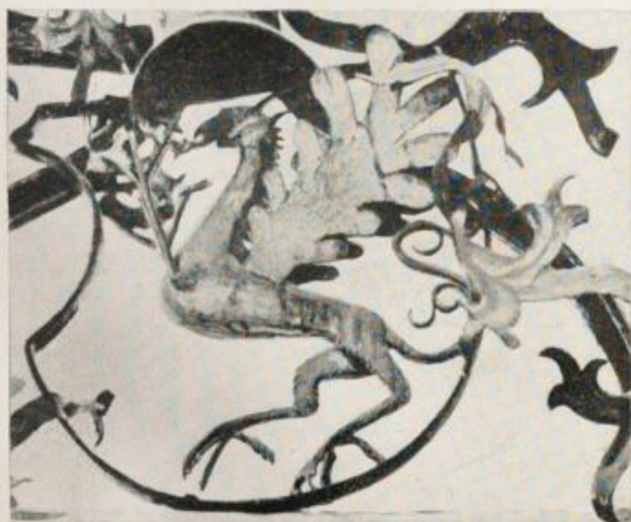
Durch Verschweißen und Vernieten zusammengefügtes Gitter mit Einzelheiten.
