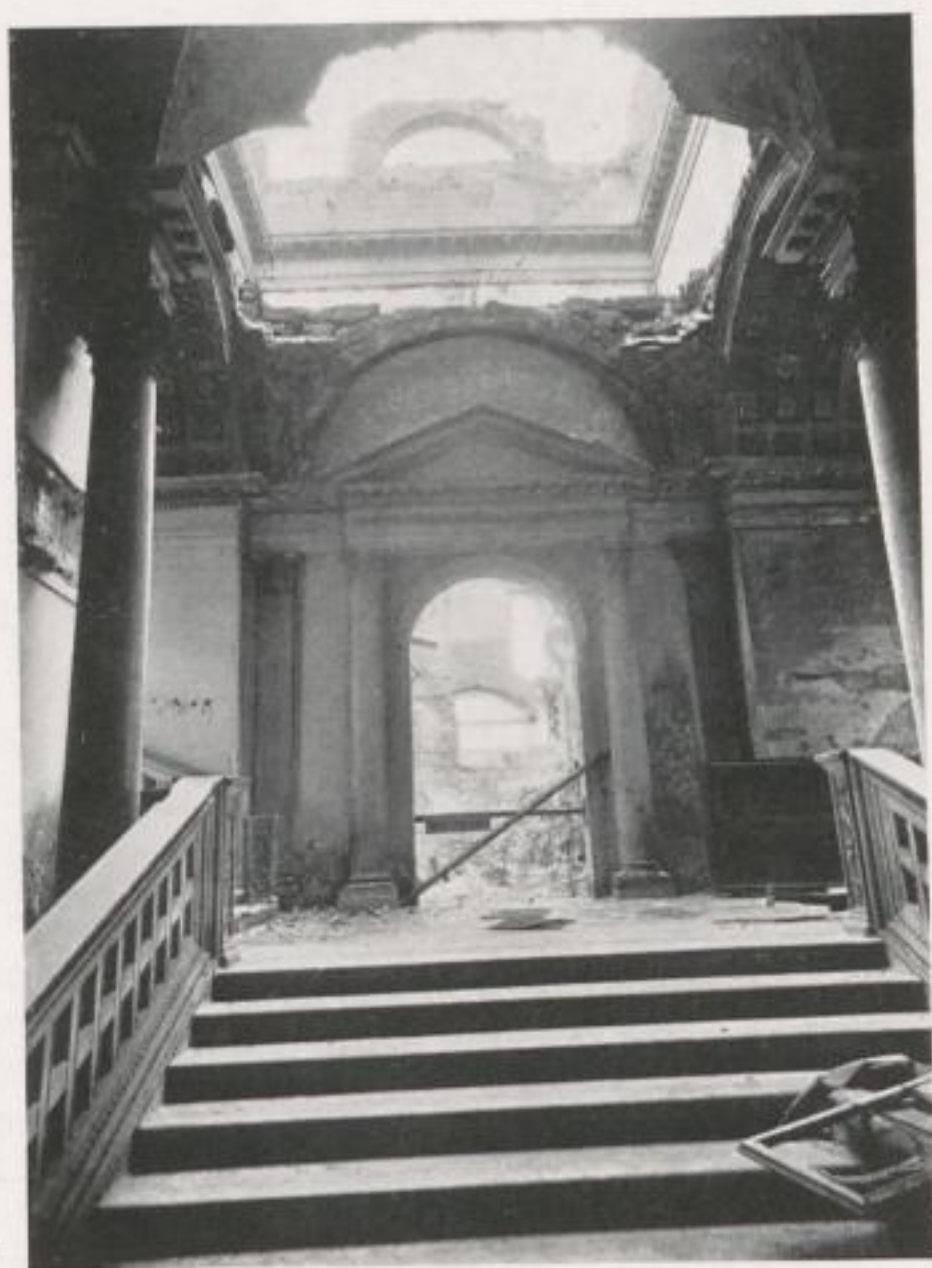
Zugang zum ehemaligen Kupferstichkabinett
