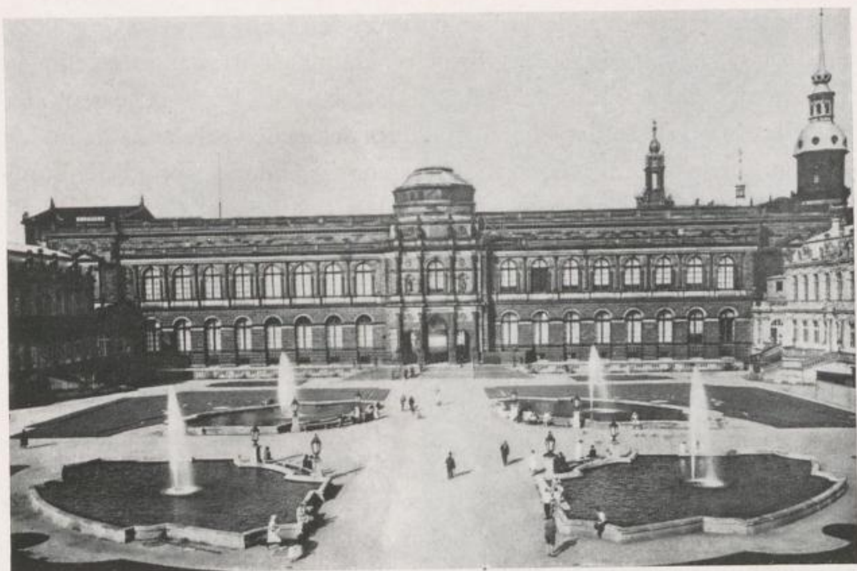
Blick auf den Semperbau vom Zwingerhof
