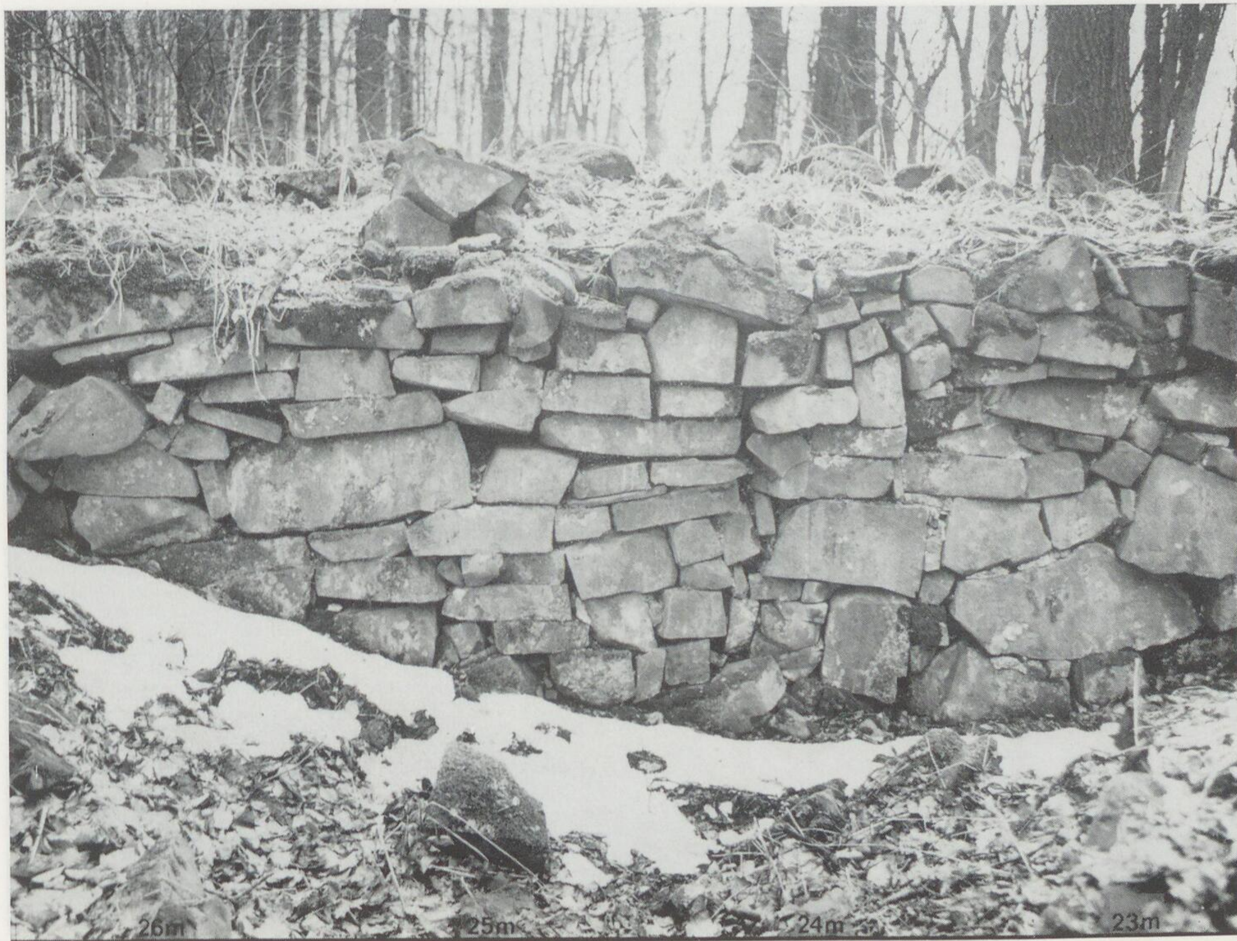
Abb. 21. Außenfassade der Akropolismauer, Nordostecke, Strecke 33–34, m 22,50–26,50. Foto: R. Spehr.
