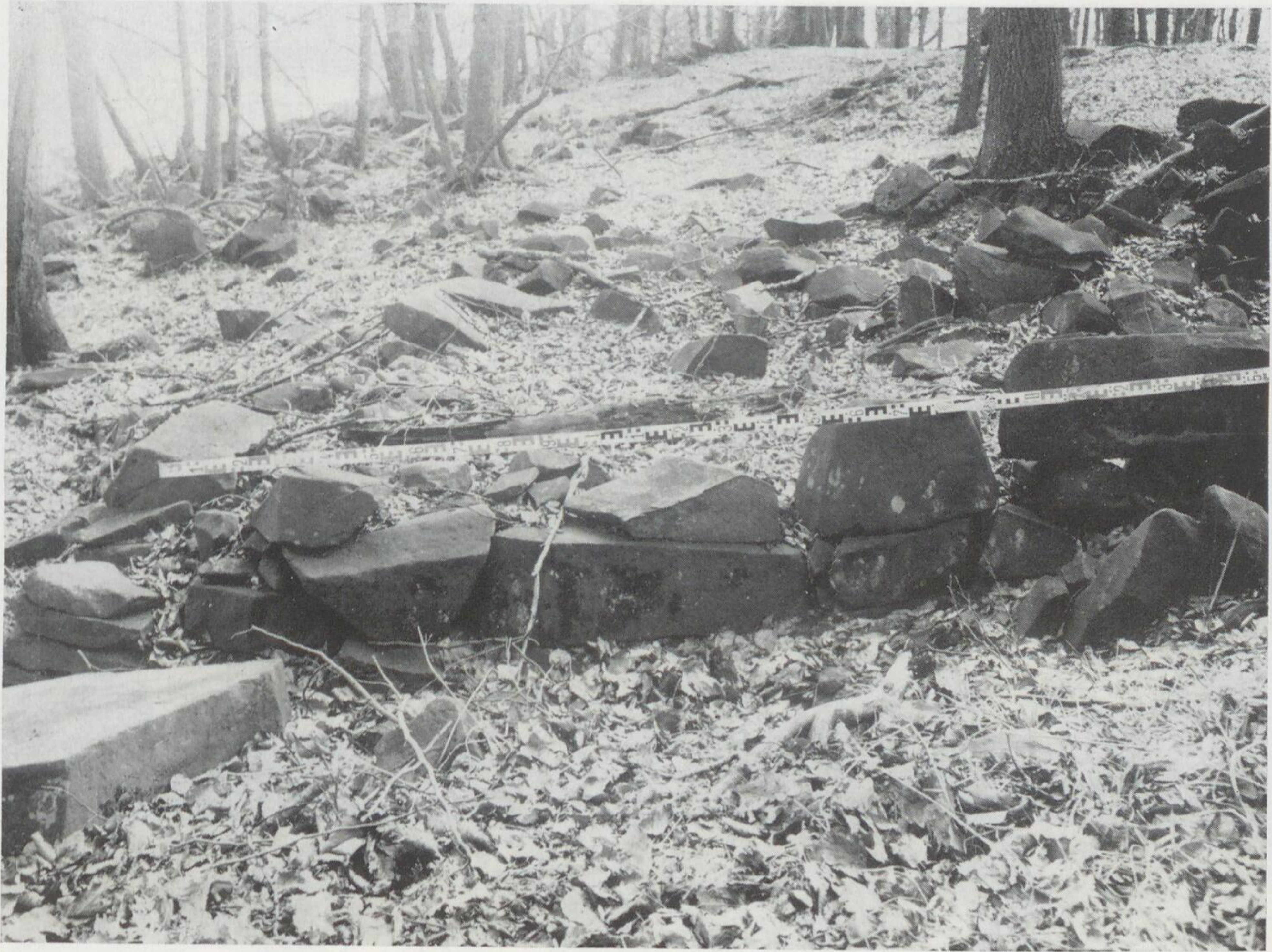
Abb. 28. „Mausoleum“ auf der Akropolis. Nordseite und Nordostecke, Zustand April 1975. Foto: R. Spehr.
