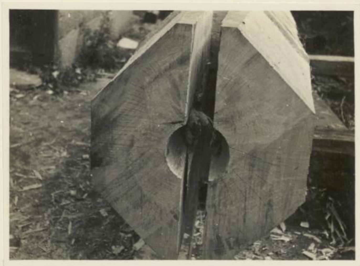
Abb. 15 Neue Welle mit Zapfenloch, Frohnauer Hammer, 1953
