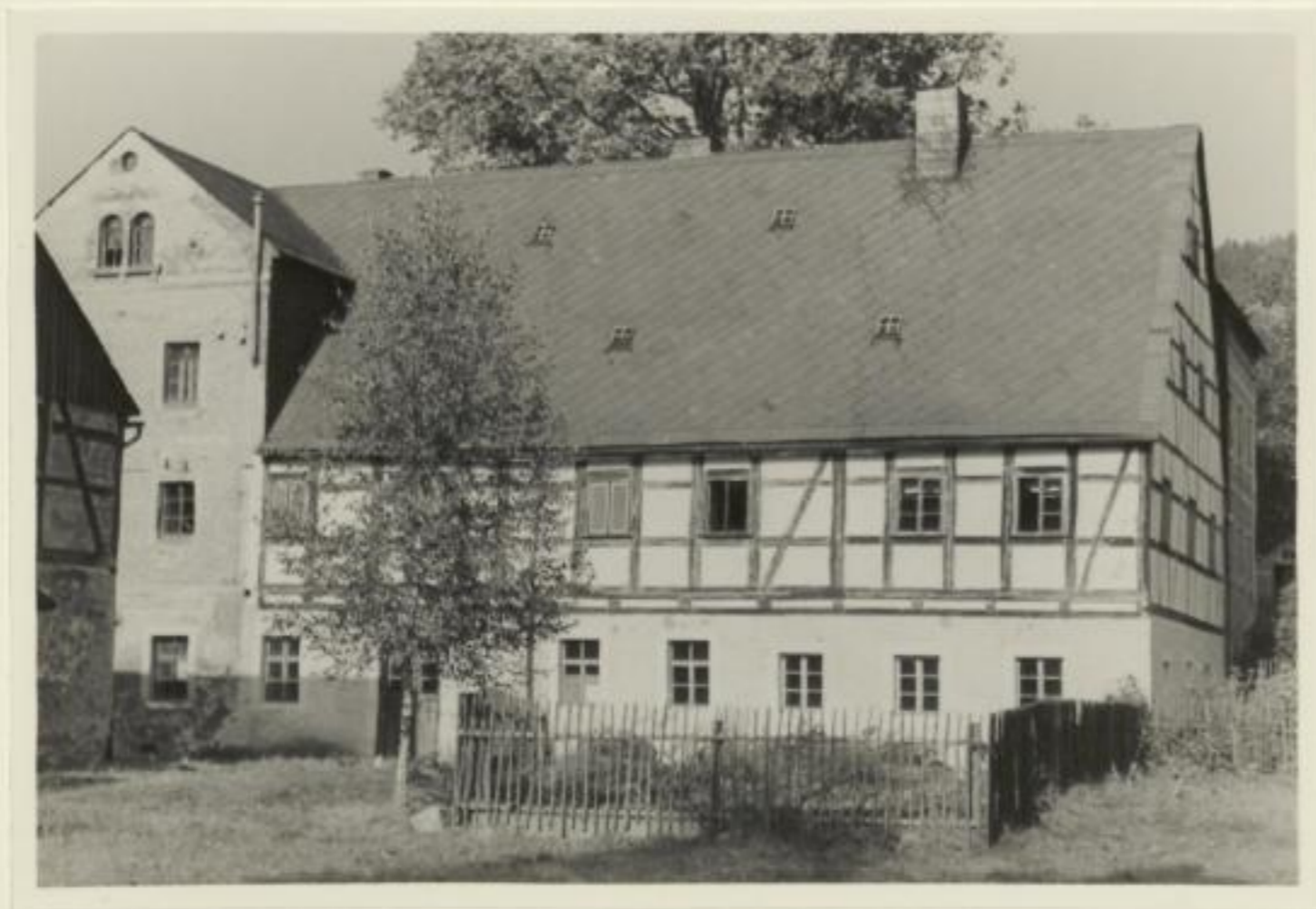
Abb. 57 Schillermühle im Gimmlitztal
