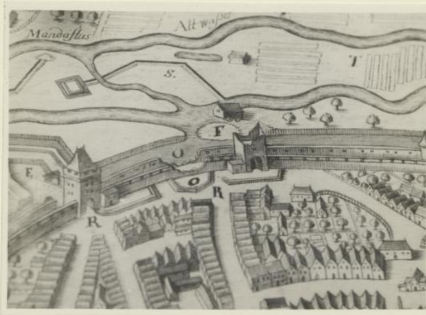
Abb. 116 Zittau, Stadtmauer mit Pfortmühle, 1632
