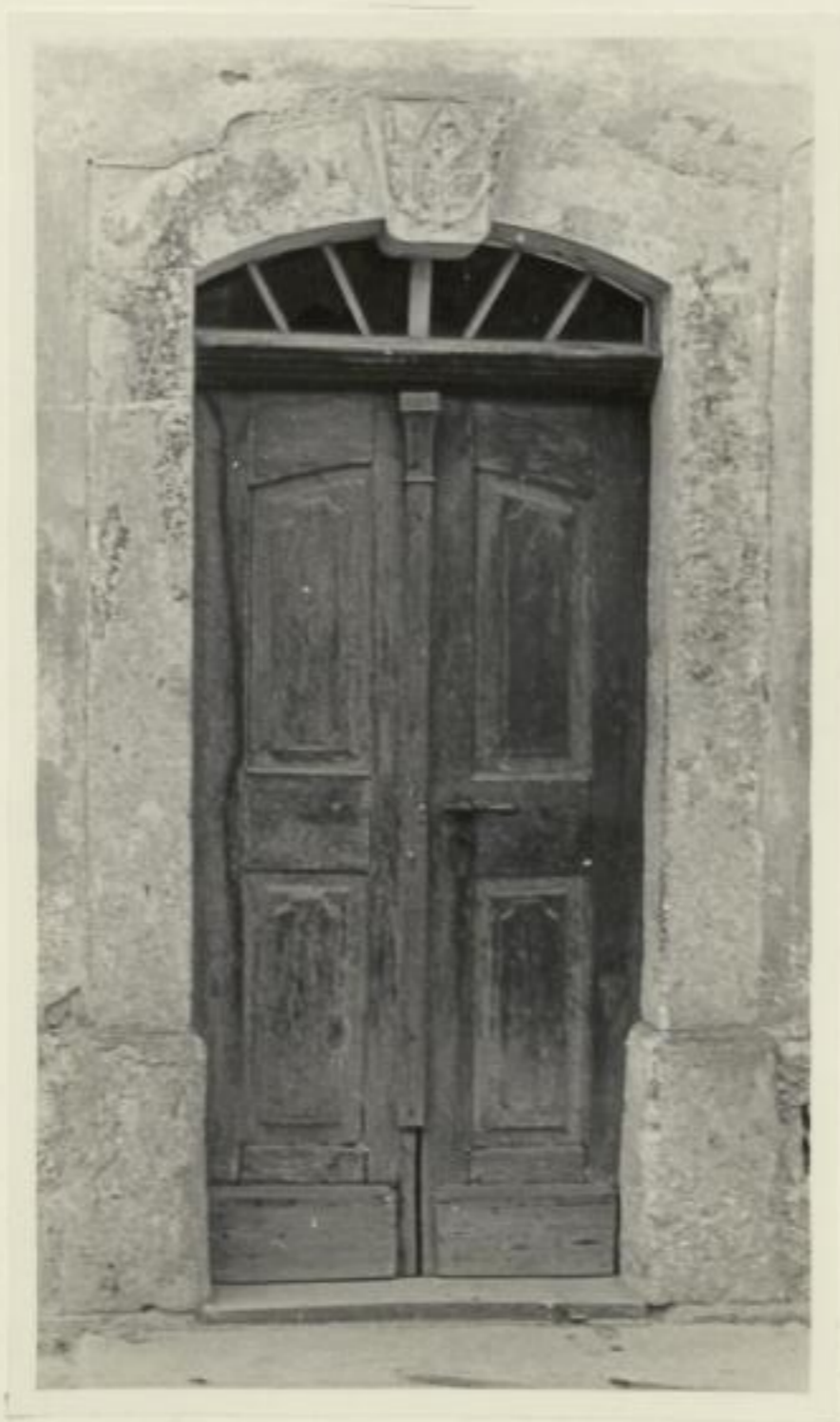
Abb. 76 ehem. Mühle in Schellenberg, Eingang
