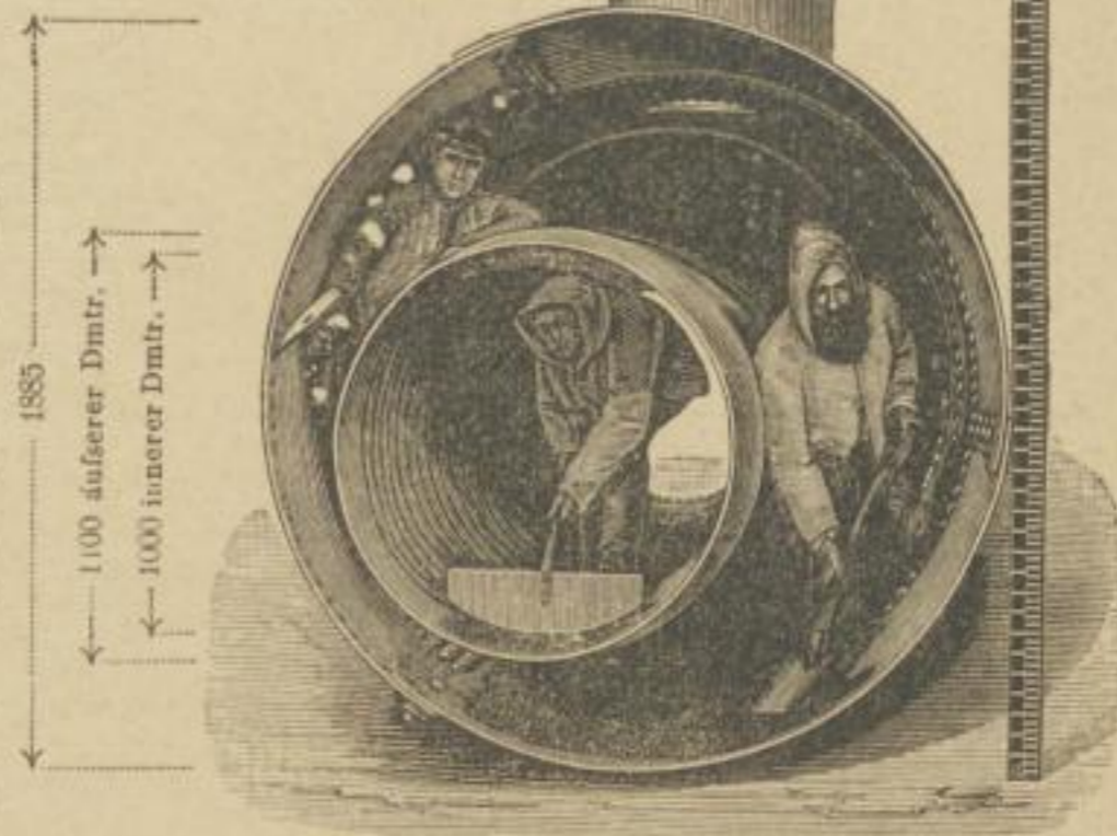
Zuerst ausgeführter Seitrohrkessel nach photographischer Aufnahme.
